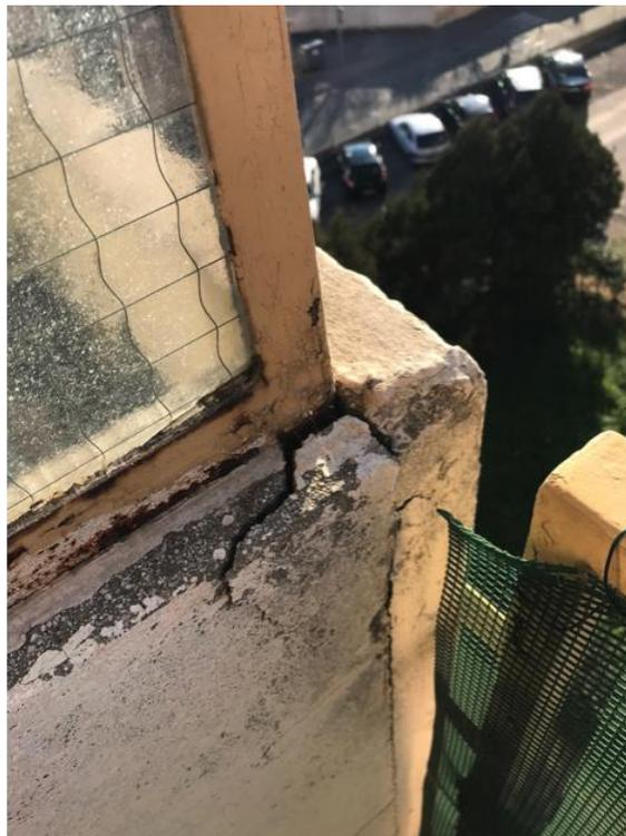
> **Les pieds de murs et de poteaux. Le phénomène est accentué par les remontées telluriques ou par l'eau stagnante en base d'ouvrage.**
