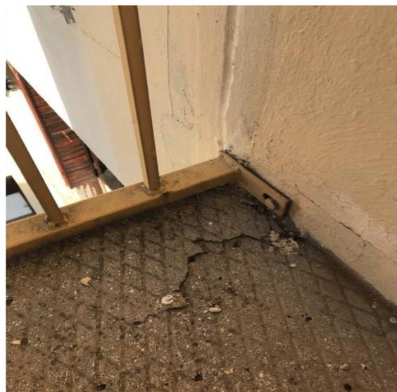
> **Les têtes de balcons, le phénomène est identique avec ici en plus un risque de chute d'ouvrage sur les balcons inférieurs ou les zones de circulation se trouvant en pieds de façades.**
