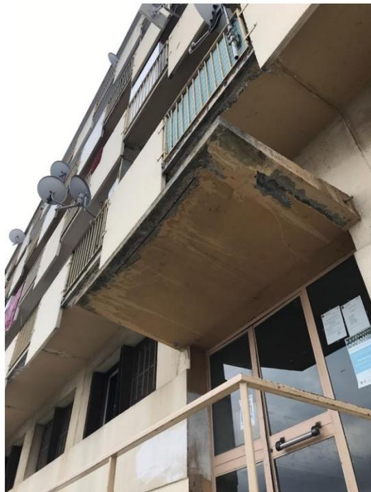
> Les ancrages d'éléments métalliques extérieurs. Ici le phénomène de carbonatation est accentué par les points de fixation qui viennent pénétrer le béton. Le problème est double avec d'abord la fragilisation du support béton et le risque de chute de l'élément métallique.
